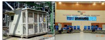
ระบบ CEMs ภายในพื้นที่โครงการ และการแสดงผลที่ห้องควบคุม
